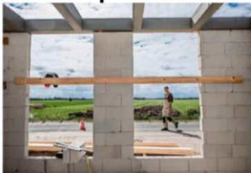
3 juli 2019: Het plaatsen van de balklaag
