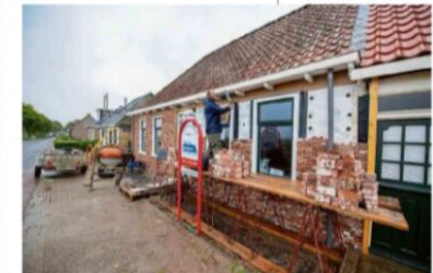
11 september 2019: Het afmeten van de buitenkant
