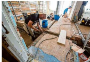
25 juli 2019: Het pand is wind- en waterdicht
